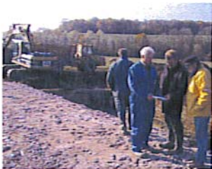
Jean-Claude Nevers, maire, en visite de chantier à la station d'épuration de Sazeray (photos Liliane Duchateau)
