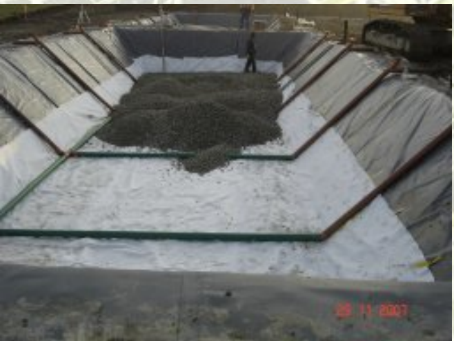
Platzieren des Filtermaterials (Apples VD-2007)
