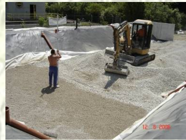
Einbringen des Filtermaterials
