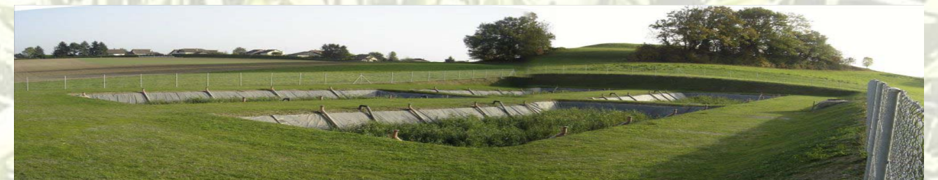
Klärschlammvererdung in der Kläranlage Apples (VD)
