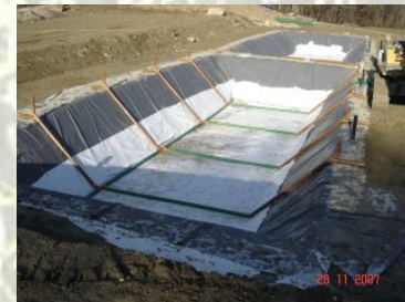
Einbauen der Drainagen
