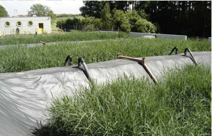
Klärschlammvererdung in der Kläranlage AIPV (Ballens-VD-2006)
