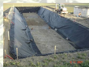
Anbringen einer Geomembrane
