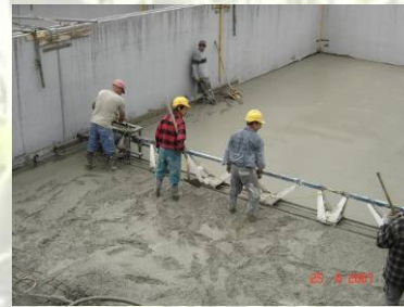
Betonieren des Bodens eines Beetes
