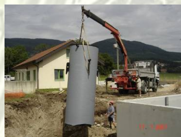
Setzen des Pumpenschachtes
