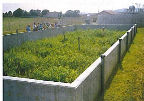
Le lit de séchage peut être entouré d'un mur en béton...
