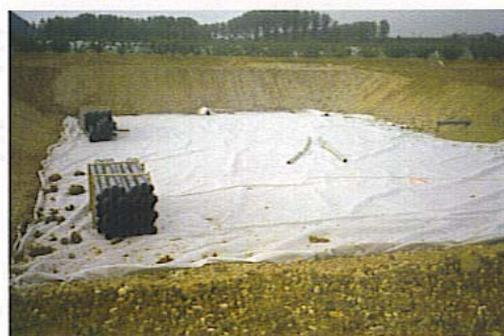
L'emplacement étanche comportera des drains connectés à des cheminées d'aération.
