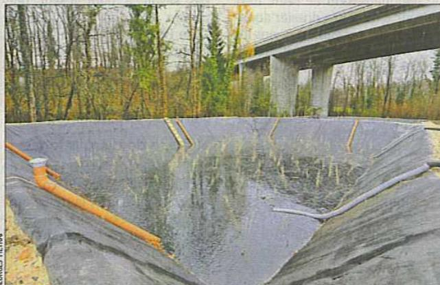
Planté de jeunes pousses de roseaux dans l'un de ses bassins, le système de traitement des boues d'épuration est en exploitation.
